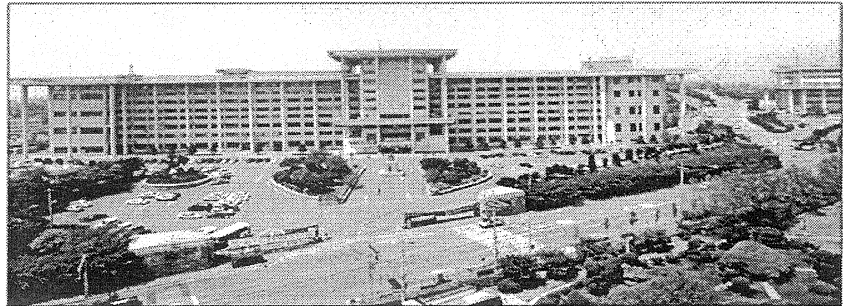
인천도시개발공사가 오는 4월부터 철거할 계획인 구 인천대 본관 건물전경.
